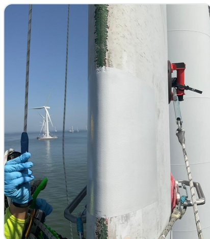
Zespół High Work podczas serwisu łopat turbin wiatrowych technikami dostępu linowego.
