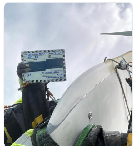
Zespół High Work podczas serwisu łopat turbin wiatrowych technikami dostępu linowego.
